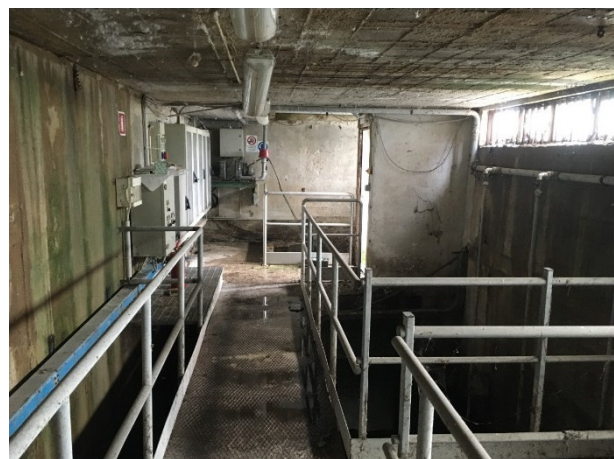
Vasca di sfioro a Lago – vista dall'interno
