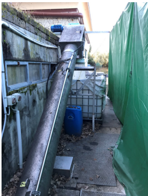
Vasca di sfioro a Lago – vista dall'esterno
