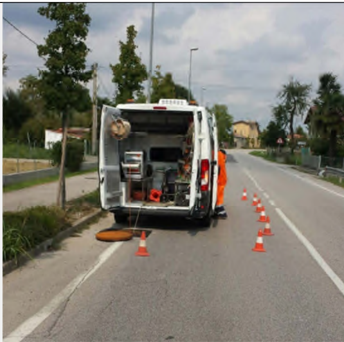
Delimitazione della zona di stazionamento del mezzo
