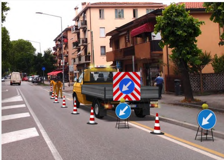
Posizionamento corretto della segnaletica e del mezzo
